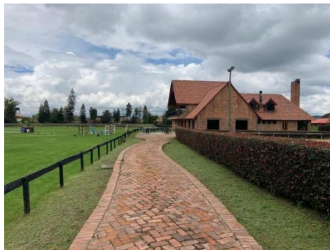
ZONA DE RESTAURANTE Y BAÑOS ALEDAÑA AL AREA DE EXPOSICION
